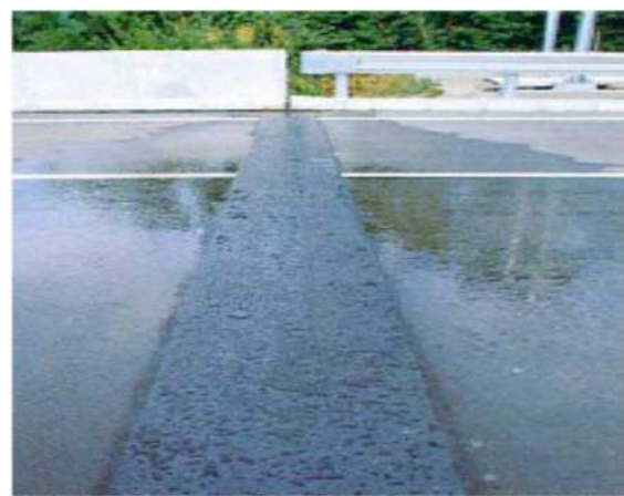
Photo 7-2 Flexible Asphalt pouring
