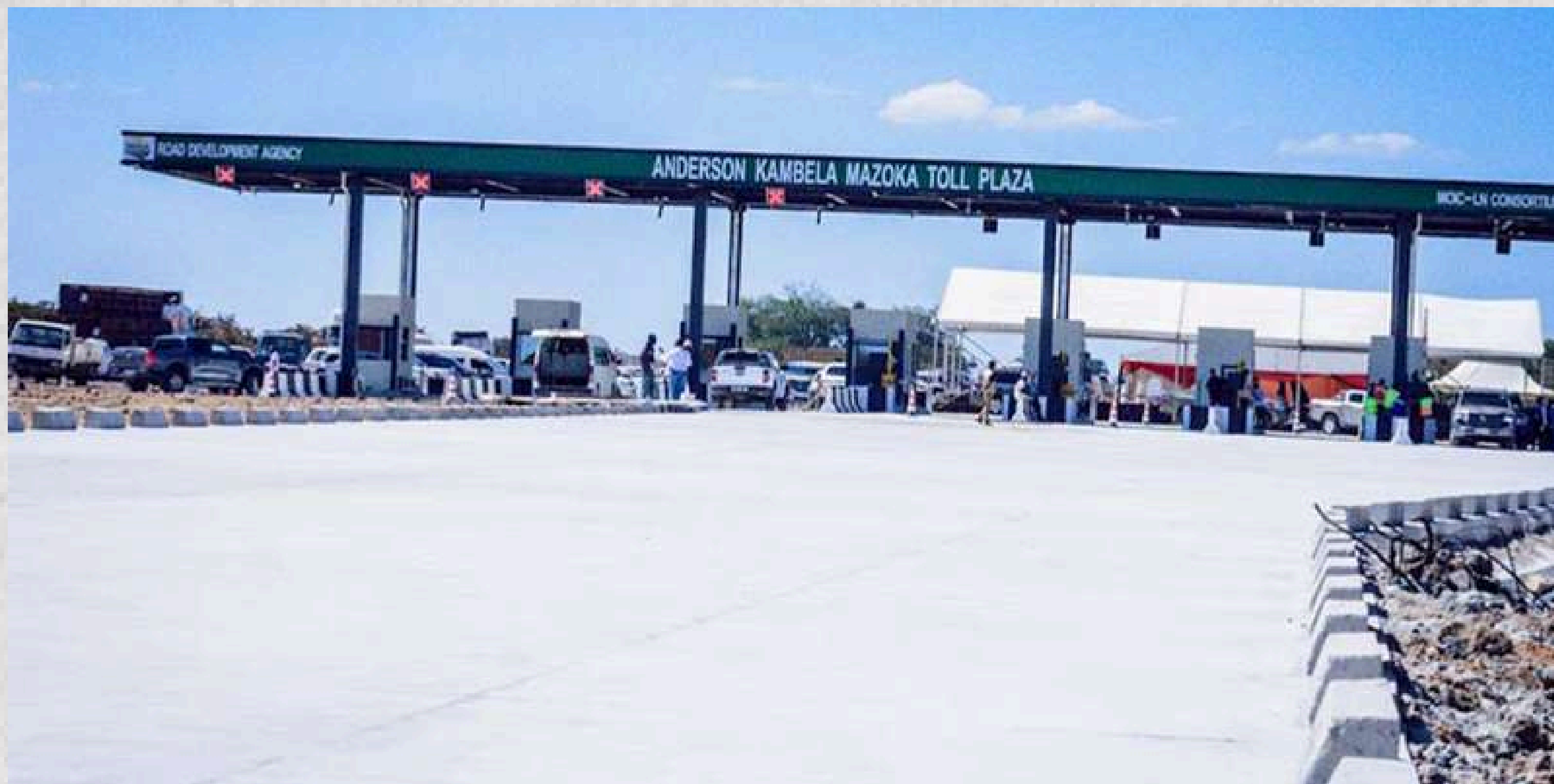
Anderson Kambela Mazoka Toll Plaza.
