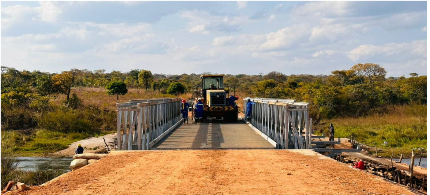
Lukulu ACROW Bridge.
